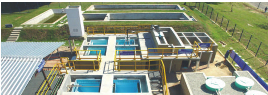
Figura 4.1 – Vista geral do CETE-UFRJ
