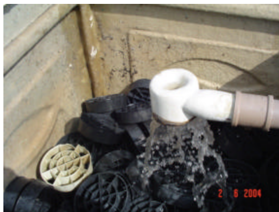
Figura 4.6 – Sistema de distribuição inicial (chuveiro único)
