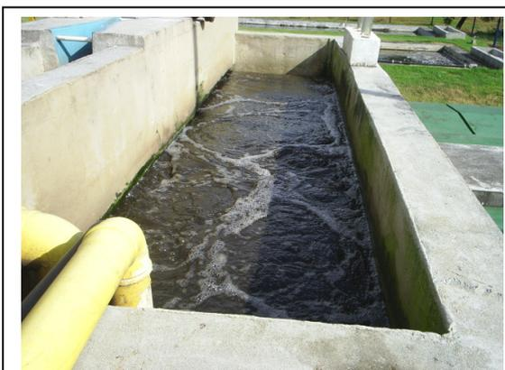
Figura 4.4a Tanque Aeração
