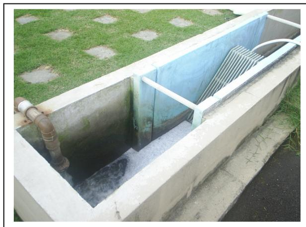
Figura 4.3a - Entrada de Esgoto e Grade.
