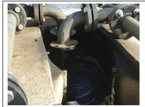
Figura 4.8d - Entrada do Lodo a Calha de Concreto
