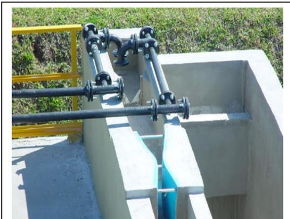
Figura 4.8c - Chegada da Tubulação a Calha de Concreto
