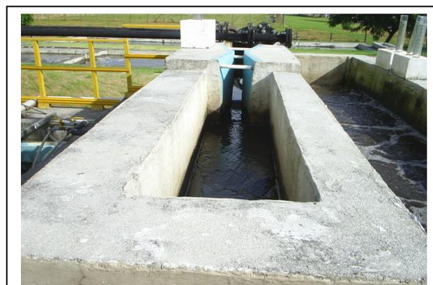
Figura 4.8e - Passagem do Lodo pela Calha Parshall
