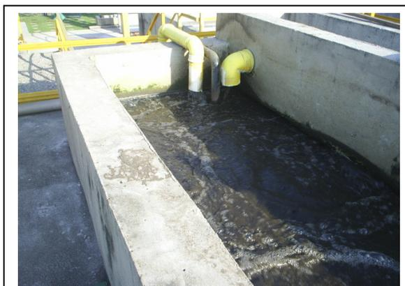
Figura 4.4b Entrada do Esgoto afluyente e de recirculação
