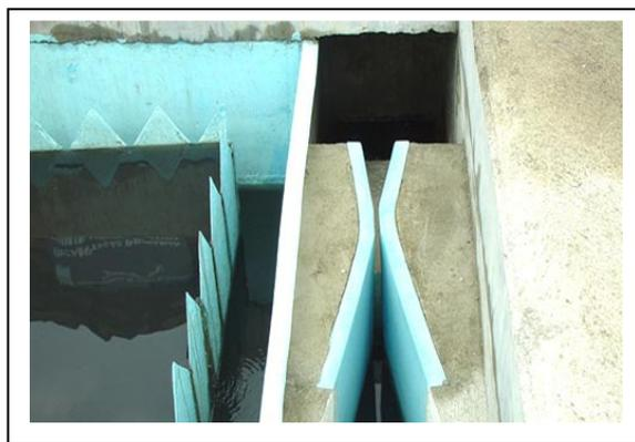
Figura 4.7b - Medidor Parshall no Decantador Secundário
