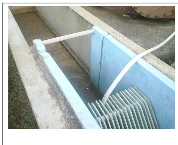
Figura 4.3b - Caixa de Areia ou Desarenador.
