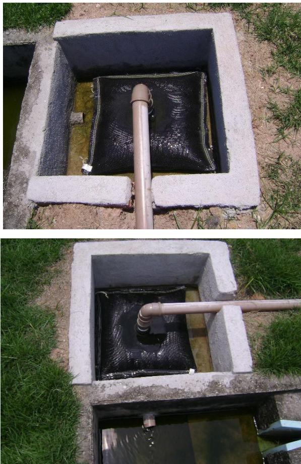
Figura 10: Detalhe do Geotube® (acima) e efluente tratado no Geotube® (abaixo)
