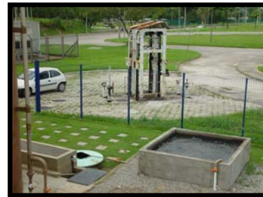
Figura 3.6 - Vista geral das instalações para a adição de lodo
