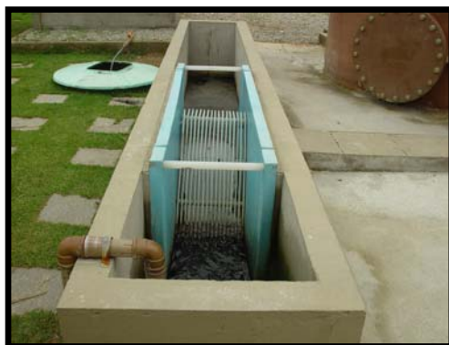
Figura 3.4 - Entrada do esgoto bruto e grade de barras
