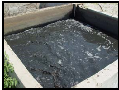
Figura 3.7 - Tanque de equalização
