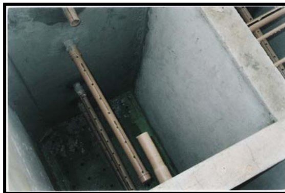
Figura 3.15 – Detalhe da tubulação dos filtros
