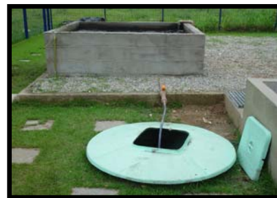
Figura 3.8 - Vista do Tanque de equalização e da estação elevatória
