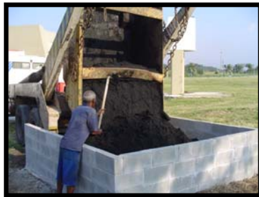
Figura 3.5 - Tanque de armazenamento do lodo
