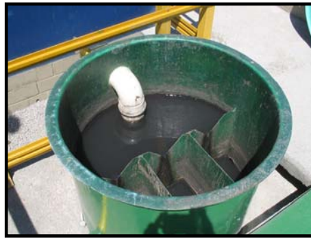
Figura 3.10 – Fotografia da caixa de distribuição
