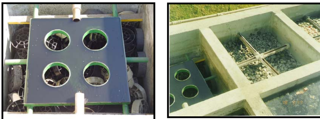
Figura 3.13– Vertedores dos conjuntos 1 e 2
